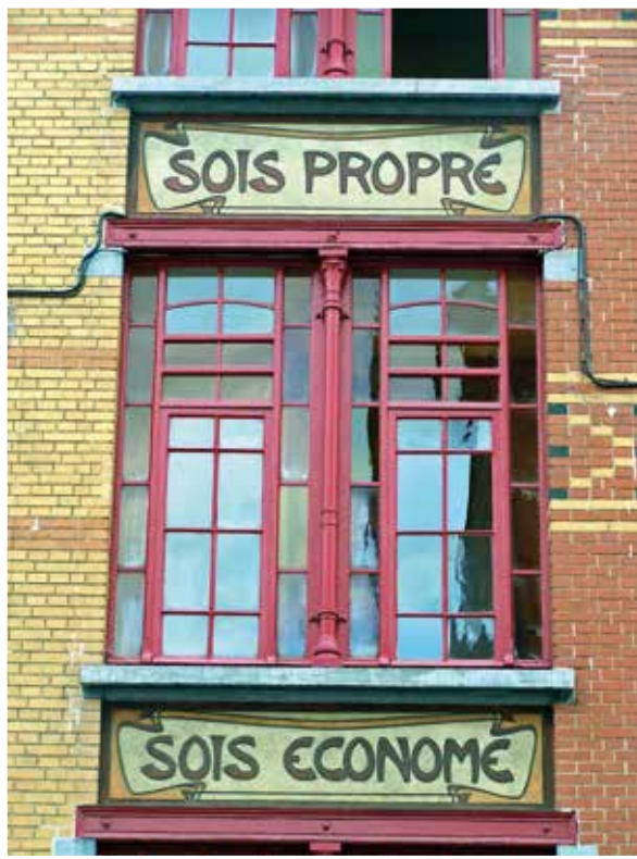
▼ Façade d'un ensemble du Foyer schaerbeekois, rue Victor Hugo 53-59 , architecte: Henri Jacobs, 1899, plan et photographie (détails)
