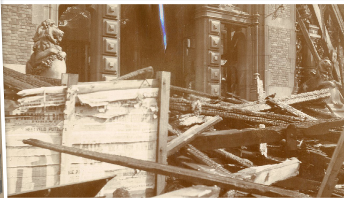
Les débris sur le perron après l'incendie, photographie [ACS]
