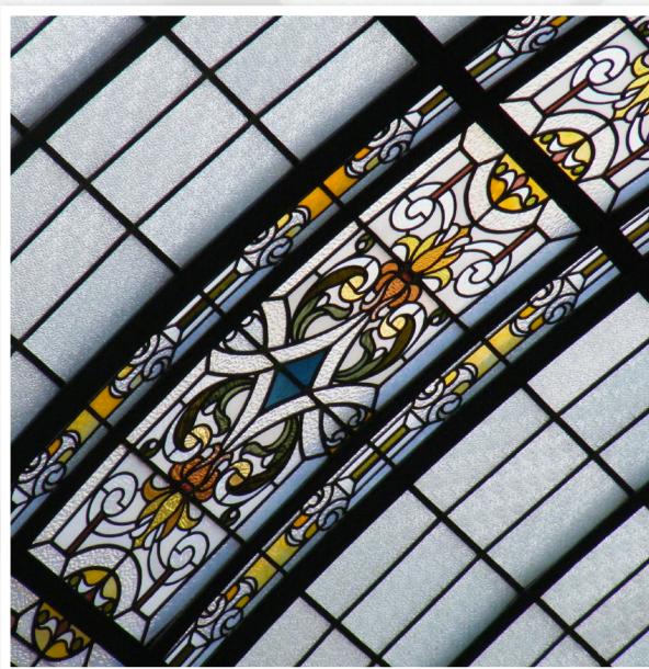
▼ Verrière de la salle des guichets (détail), photographie 2011.
