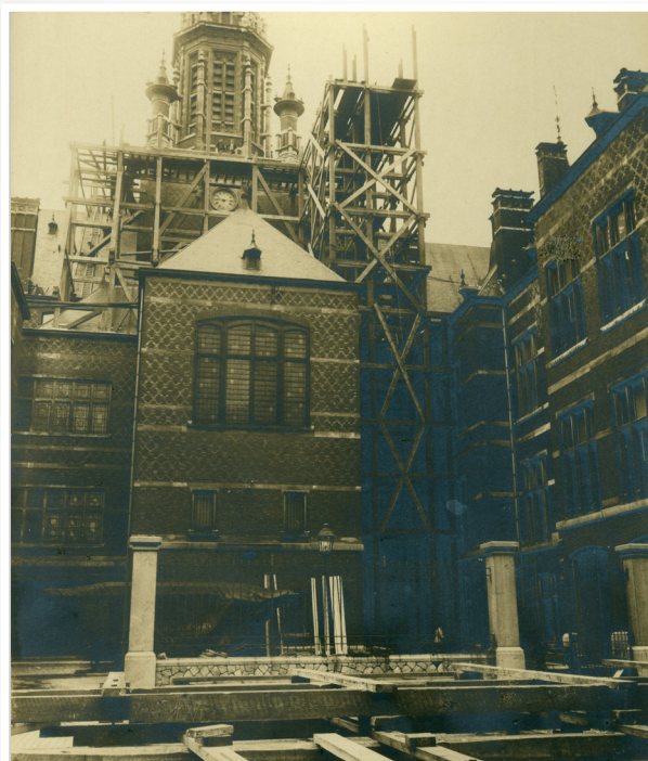
L'arrière de l'hôtel communal pendant la restauration, v. 1910 [ACS]
