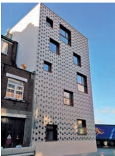
● Angle rue Navez et rue d'Anethan Hoek van de Navezstraat en d'Anethanstraat
