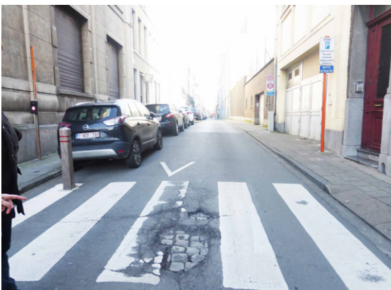
rue du Secours / Hulpstraat
