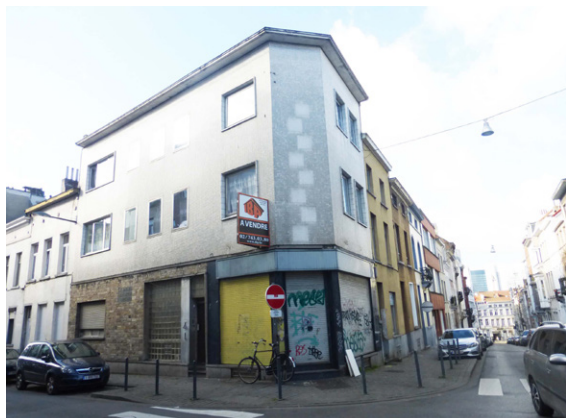
Rue de la Poste/ Poststraat 189-195
