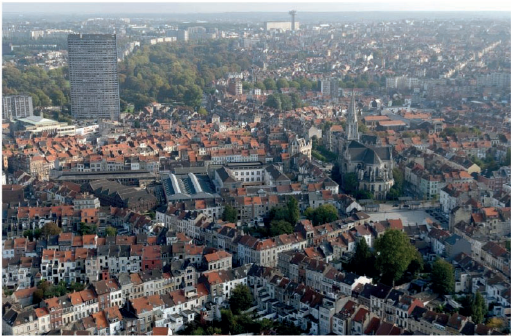
vue aeriene / luchtbeeld
