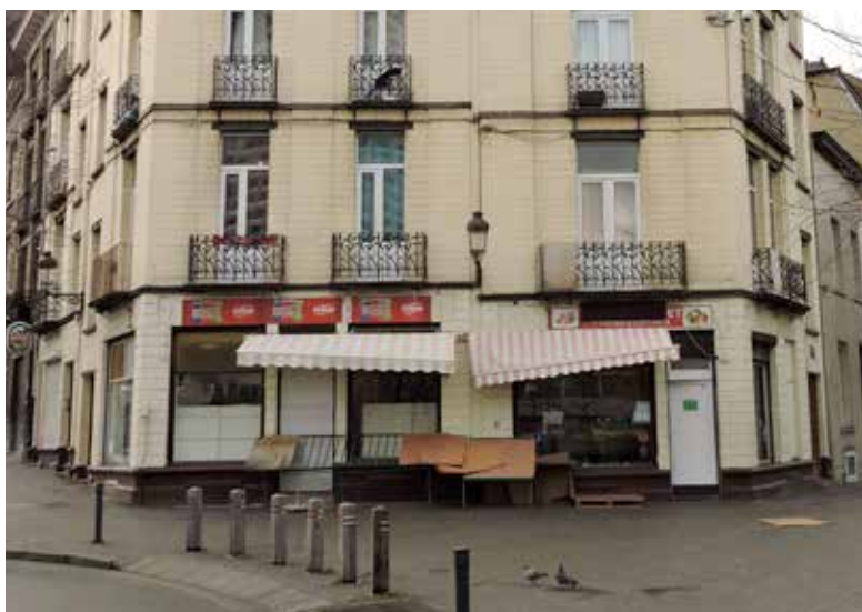
Exemple de commerces, de rez de chaussée dégradés ou abandonnés
