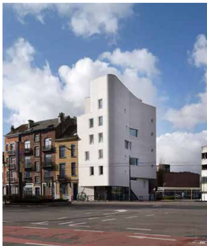
Logements Navez, Bruxelles, MSA - Vplus
