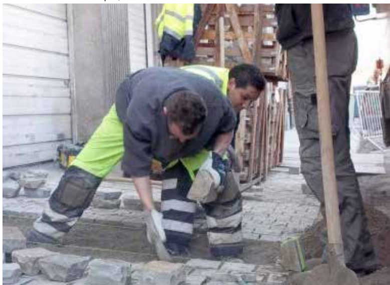
Rénovation de trottoir, JST Asbl, CQD Coteaux-Josaphat
