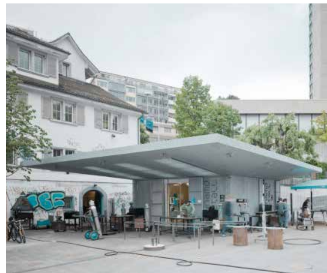
Dynamo metal workshop, Zurich, Phalt Architekten
