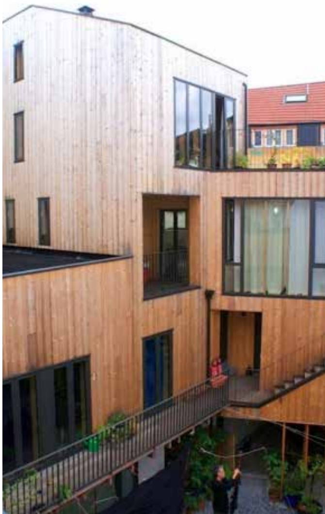
Ateliers-Logements, Bruxelles, Vplus
