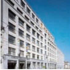
❸ Ancien immeuble RTT COCOF France gemeenschapscommissie
