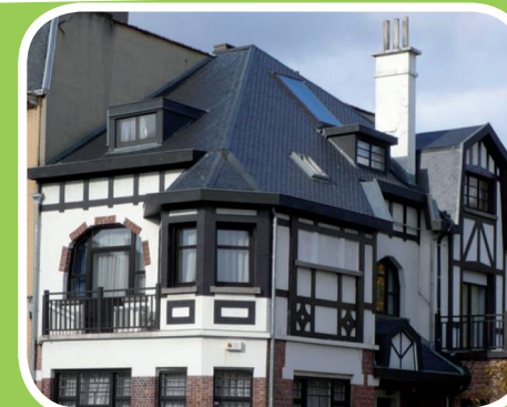
Toiture d'un immeuble style cottage
