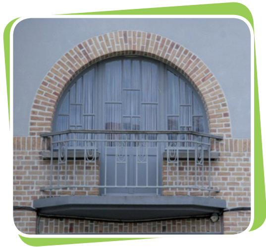
Châssis faisant partie des éléments patrimoniaux de façade
