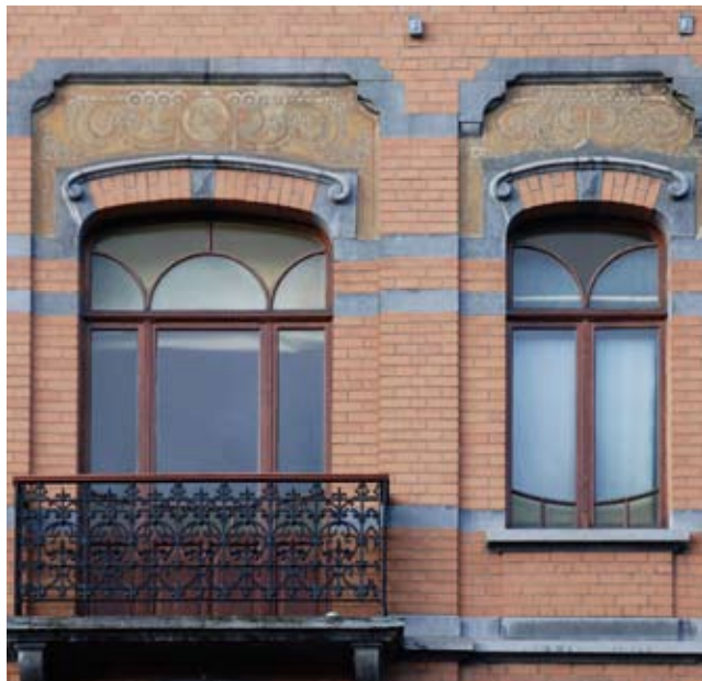
Fenêtres à deux ouvrants surmontés d'une imposte fixe, Schaerbeek, rue des Pâquerettes 60, vers 1900.
