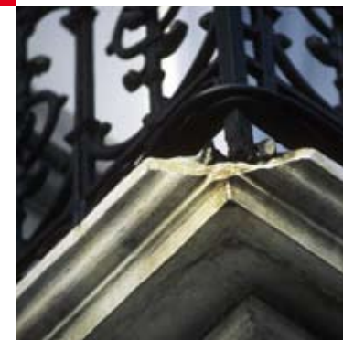
Le gonflement du métal sous l'effet de la rouille, combiné au gel, provoque des cassures dans l'assise en pierre. Un défaut de fixation du garde-corps représente un danger potentiel.
