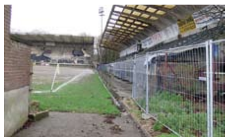
Le stade du Crossing: une rénovation attendue... aussi par les clubs résidents!
