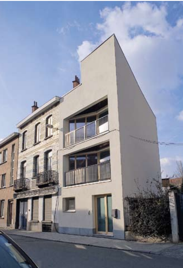
1 er prix: rue Wauters 61 - architecte Ines Camacho. © A.Rocca.
