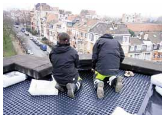
Végétalisation d'une toiture rue Eekhoud à Schaerbeek (quartier Helmet). Pose de la couche de rétention d'eau.
