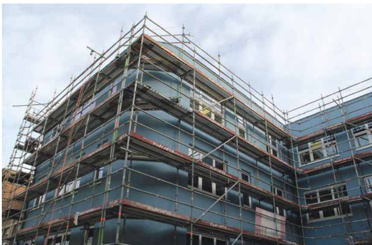
Le remplacement des châssis et des travaux d'isolation à l'école La Vallée, Grande Rue au Bois
