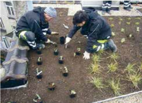
Formation à la pose de toitures vertes
