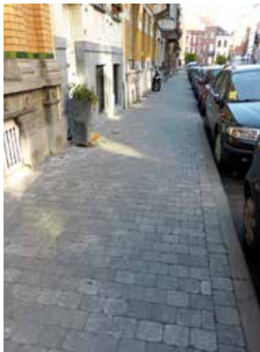
Béton rustique / Rustieke betontegels
