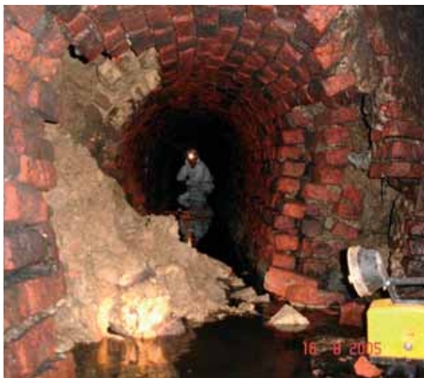
Les égouts ont été construits il y a 100 ans à 9 mètres sous terre rendant toute intervention périlleuse. © Source IBRA
