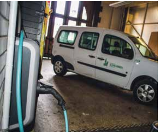
Le service Accueil Expédition utilise une voiture électrique. Une borne de recharge est installée au sein de l’Hôtel communal.
