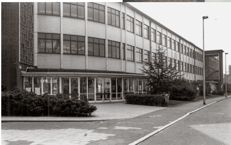
Ouverte en 1970, l'Ecole 16 avait cette apparence avant les travaux.
