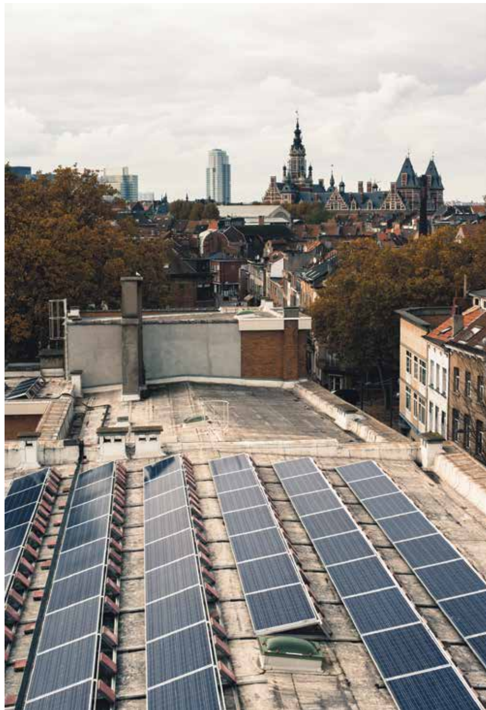
Een actie van het Schaerbeekse 'Klimaatplan': de plaatsing van zonnepanelen op de daken van bepaalde gebouwen van de gemeente.
