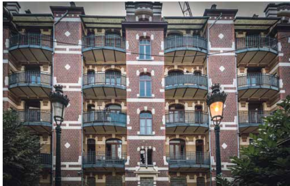
La rénovation de 5 immeubles Art Nouveau de la rue L'Olivier vient d'être lancée.
