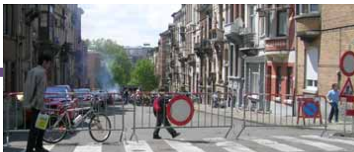
Des barrières NADAR pour un petit coin de paradis
