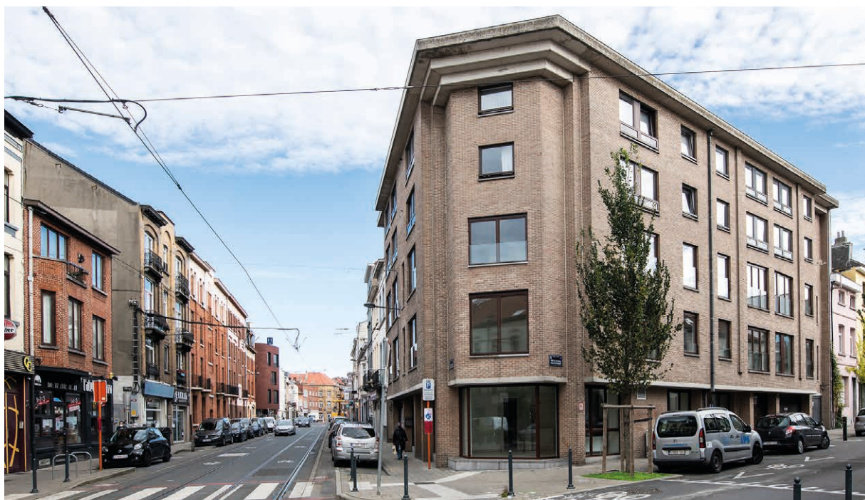
En février 2021, le Foyer Schaerbeekois a inauguré un immeuble à l'angle de la chaussée de Helmet et de la rue du Corbeau.
