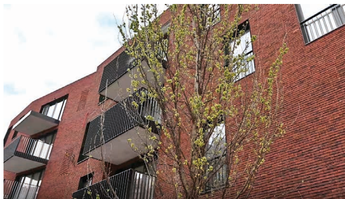
L'immeuble Van Droogenbroeck pendant la démolition et après sa reconstruction.
