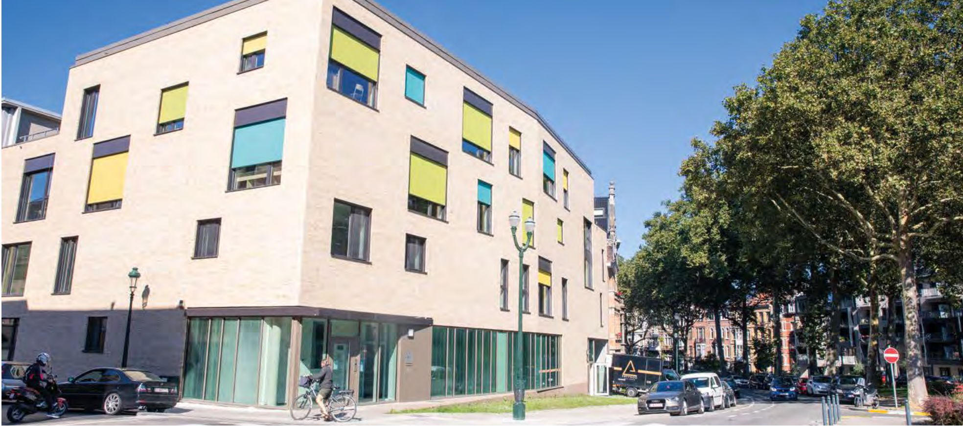
Le budget communal permet à Schaerbeek de rénover le bâti de nos quartiers et d'investir dans de nouvelles écoles (ici le nouveau bâtiment de l'Institut Frans Fischer).
