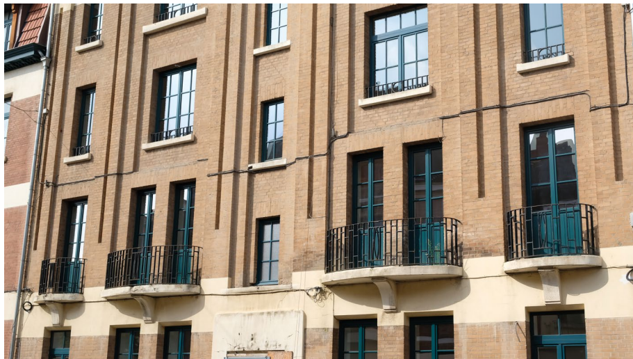
La façade de l'immeuble situé aux 63-65 de la rue Jules Destrée.
