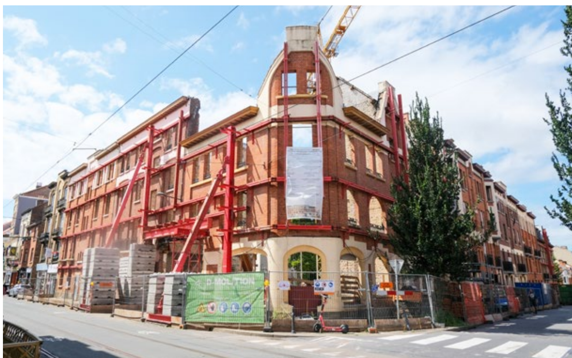
Le nouveau chantier en question, entre la chaussée de Helmet, la rue Van Droogenbroeck et la rue Séverin.
