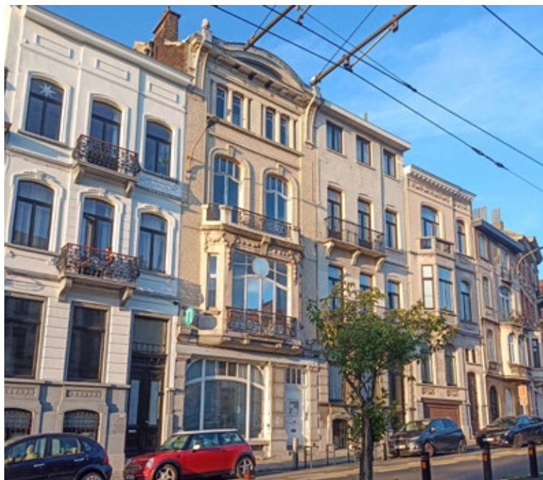
Het gebouw De Kattepoel : avenue Rogierlaan 214
