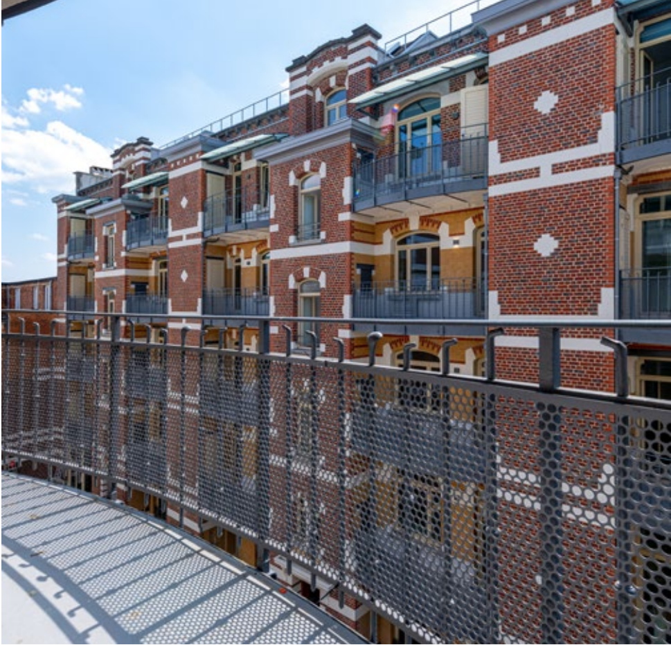
Construite entre 1903 et 1905 par Henri Jacobs, la cité de la rue L’Olivier a fait l’objet d’une rénovation complète, achevée en 2022.
