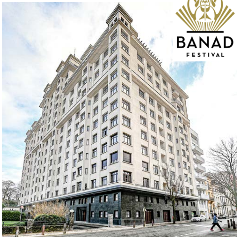
Les Pavillons français, rue du Noyer 282. Architecte : Marcel Peeters. 1931-1934.
