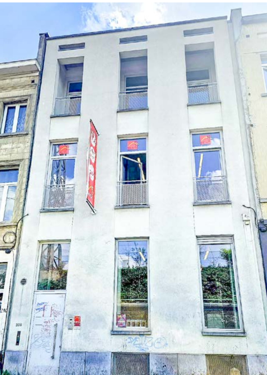
Le bâtiment communal qui se situe au 208 de la rue d'Aerschot accueille depuis peu 3 associations : l'Espace P..., UTSOPI et le Projet Lama.
