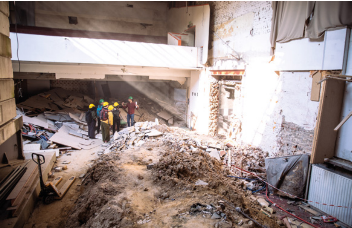
Le chantier du SKA a permis de regrouper trois bâtiments en un seul, en ouvrant des passages pour relier toutes les salles entre elles.
