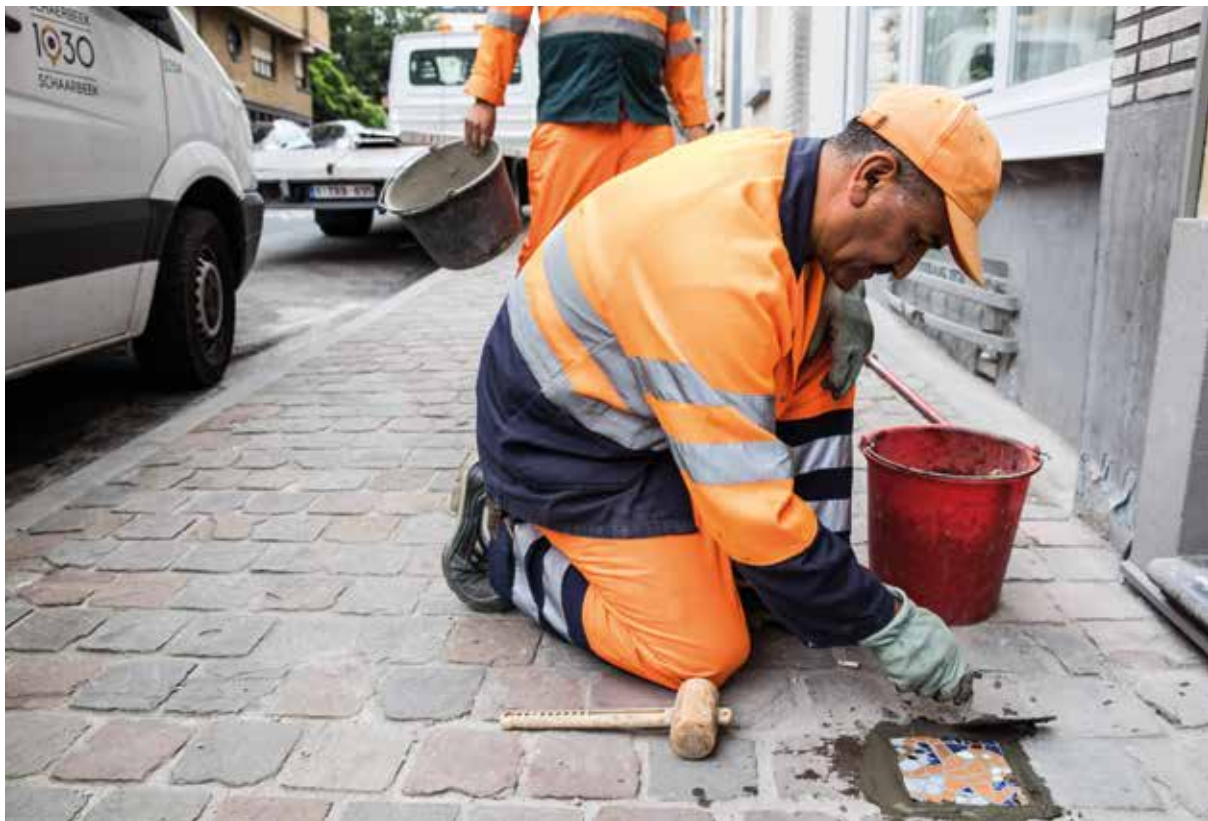
À la demande de citoyen-ne-s, le service Voirie peut installer des pavés mosaïques dans les trottoirs schaarbeekoïses. Info : 1030.be/pave-mosaïque
