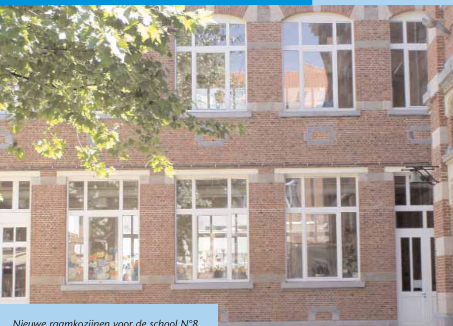
Nieuwe raamkozijnen voor de school N°8
