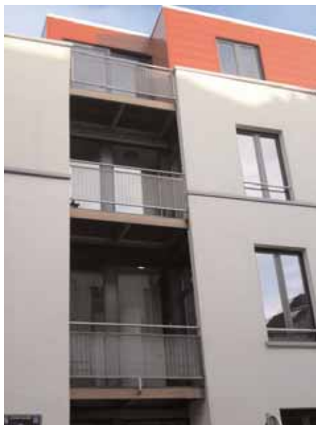
Opération en cours de finalisation Contrat de quartier Aerschot
