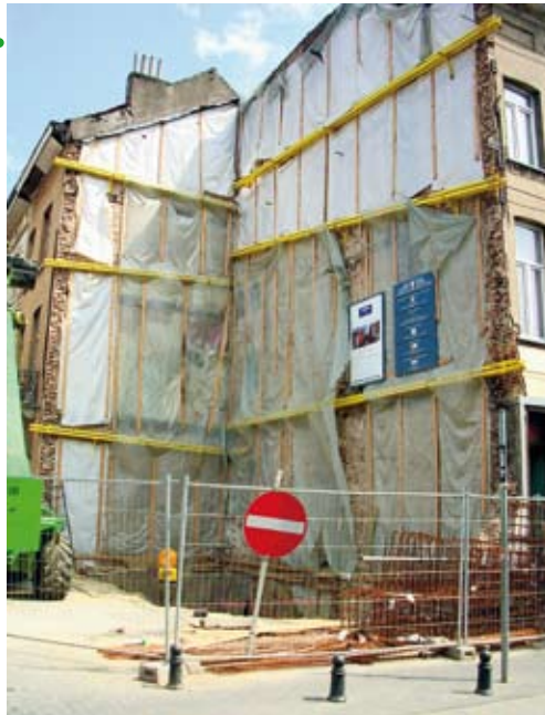
Contrat de quartier Aerschot-Progrès 2001-2005 Angles Aerschot – Liedts Construction de 6 logements © RenovaS
