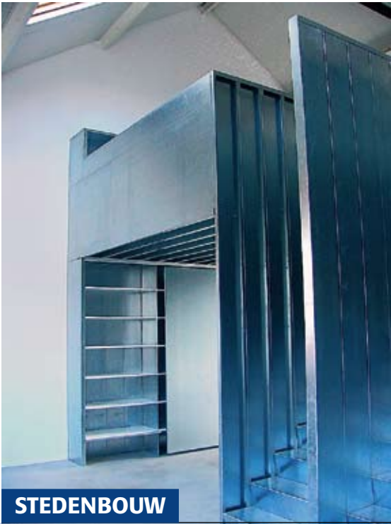
La Lustrerie, rue des Palais – Arch. Pierre Blondel
